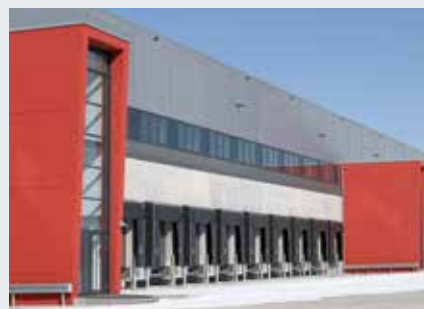
Immogate – logistické centrum, Mníchov
