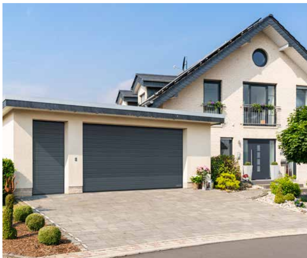
DOLE. Woodgrain, antracitová sivá RAL 7016 so vzhľadovo rovnakými vedľajšími dverami a hliníkové domové dvere ThermoSafe motív 501
